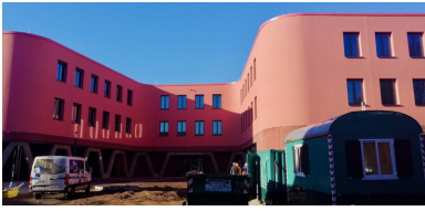
Der Schulneubau kurz vor der Fertigstellung.
